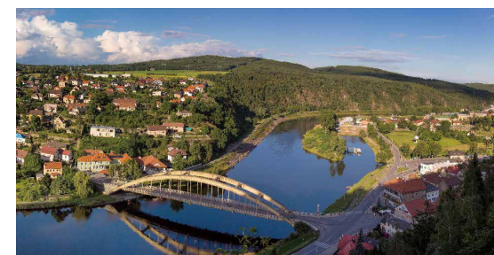
图9：捷克的伏尔塔瓦河景观
