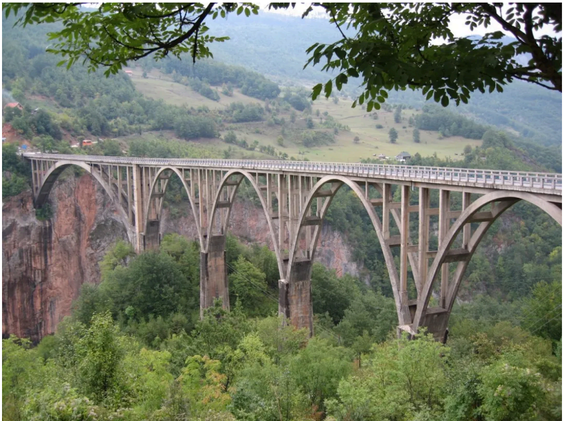
图5: 塔拉河峡谷大桥 [5]
