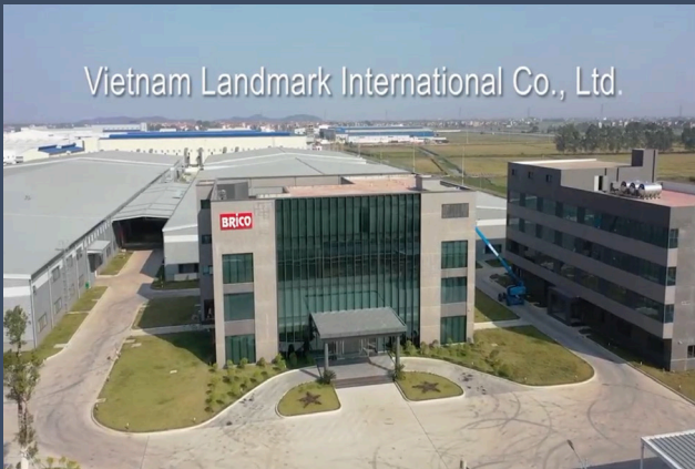
Brico 越南工厂外部
