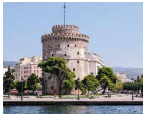
图9：塞萨洛尼基的标志性建筑之一：白塔 16
